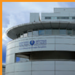
Госпиталь им. Жоржа Помпиду Париж
